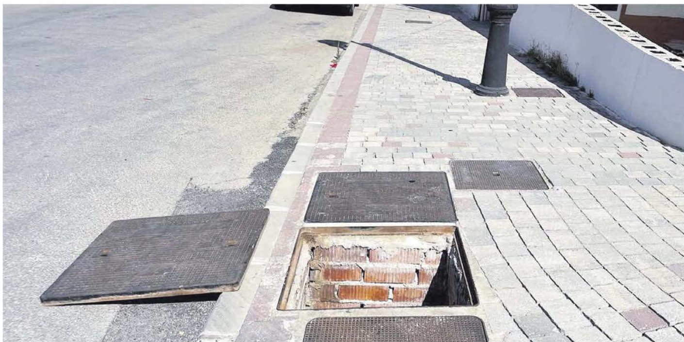
Instalación doble piloto reductora en Cártama.
