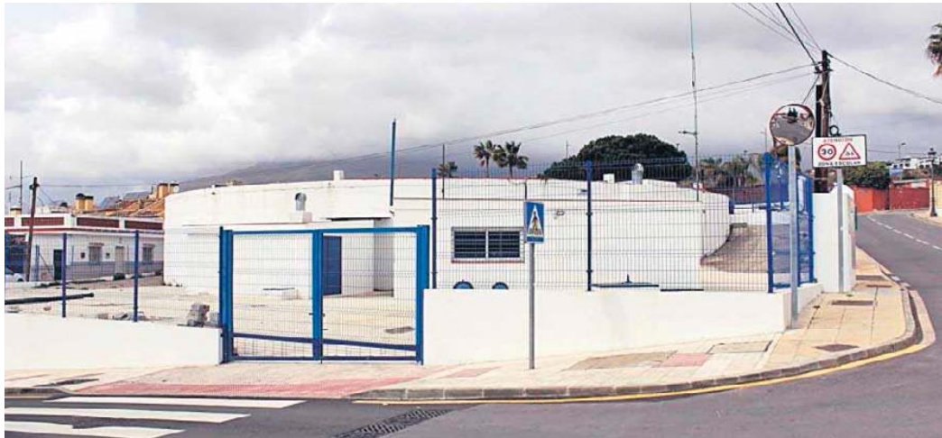
Instalaciones de la desaladora de Marbella.
