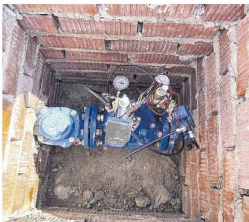
Instalación de pilotos de control.
