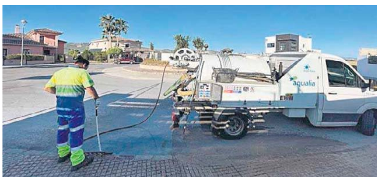
Un operario de Aqualia limpia una de las alcantarillas de Baena.
