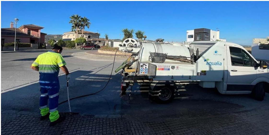
Un operario de Aqualia limpiando los imbornales de una calle de Baena. Foto: Aqualia.
